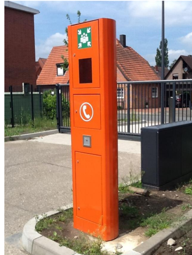
Beispiel: Sammelstellensäule mit Sprechverbindung und Notfalldepot
