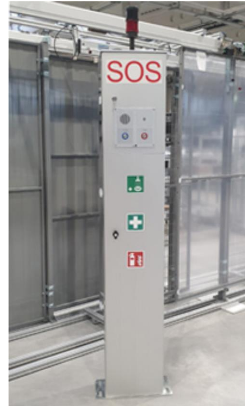
Beispiel: Notfallterminal Aluminiumsäule mit Sprechverbindung, Augendusche, Notfalldepot und Feuerlöscher
