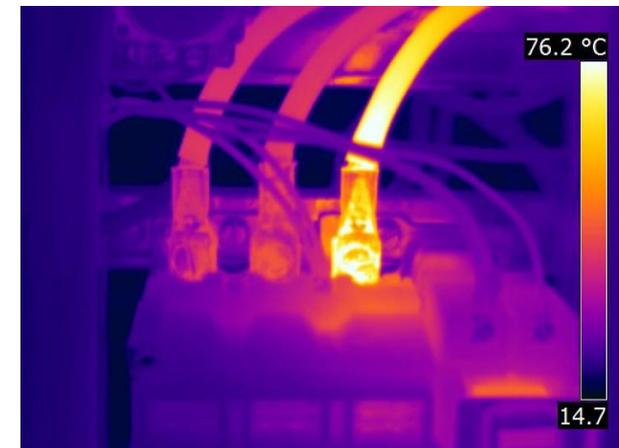
Sicherheitskritische Wärmeentwicklung durch fehlerhaften elektrischen Kontakt
