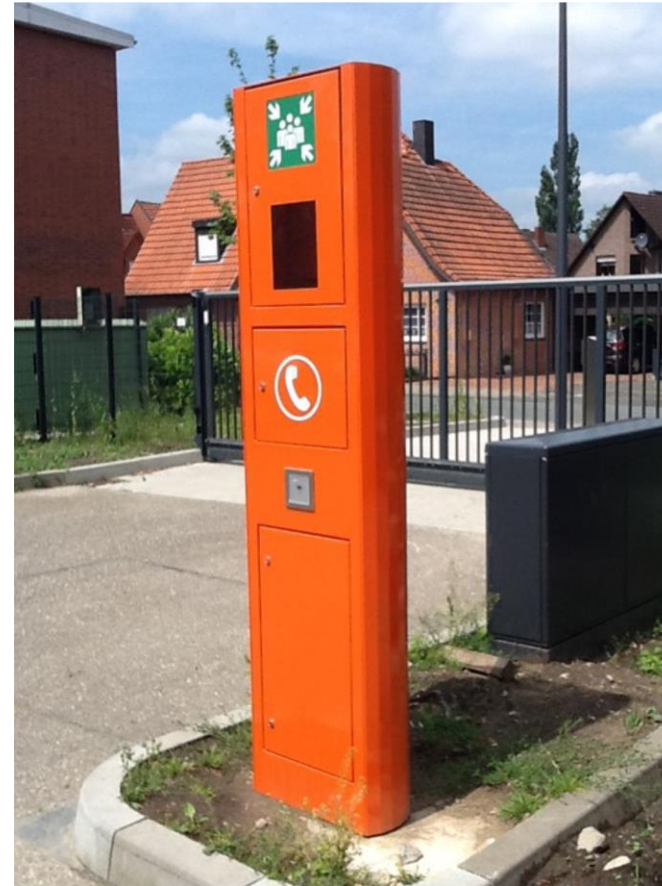
Beispiel: Sammelstellensäule mit Sprechverbindung und Notfalldepot
