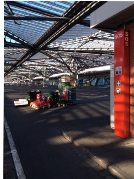
Beispiel: Notfallterminal mit Sprech- verbindung, Notfalldepot und AED
